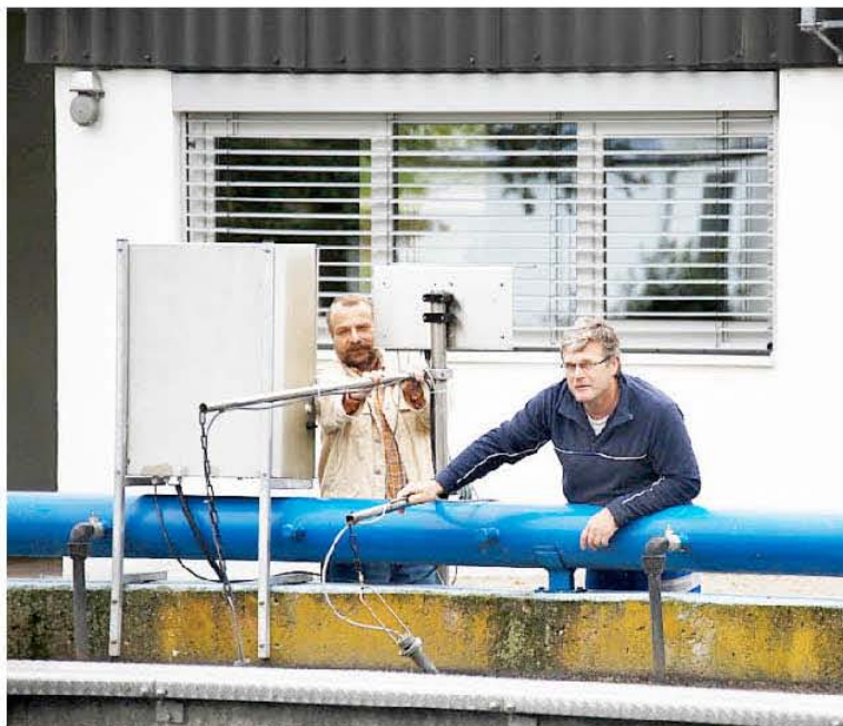
Der Stegauracher Klimabeauftragte Andreas Geck (l.) und Klärwärter Manfred Hofmann messen die Temperatur des Abwassers. Mit der Wärme soll das Betriebsgebäude der Kläranlage beheizt werden. Foto: M. Hoch
