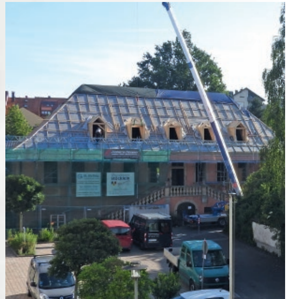
Foto: Die Gauben wurden neu ausgerichtet.
