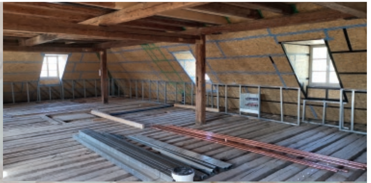
Fotos: Der Dachstuhl vorher und während der Bauarbeiten.
