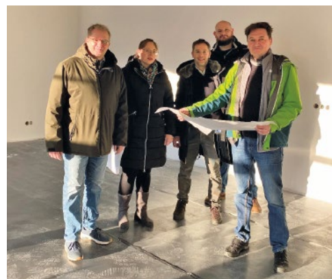
Bürgermeister Thilo Wagner (v.l.n.r.), Veronika Zweyer (BRK), Jochen Eis (Architekt), Tobias Luft (Gemeinde Stegaurach) und Michael Ruthrof (BRK) informieren sich auf der Baustelle.
